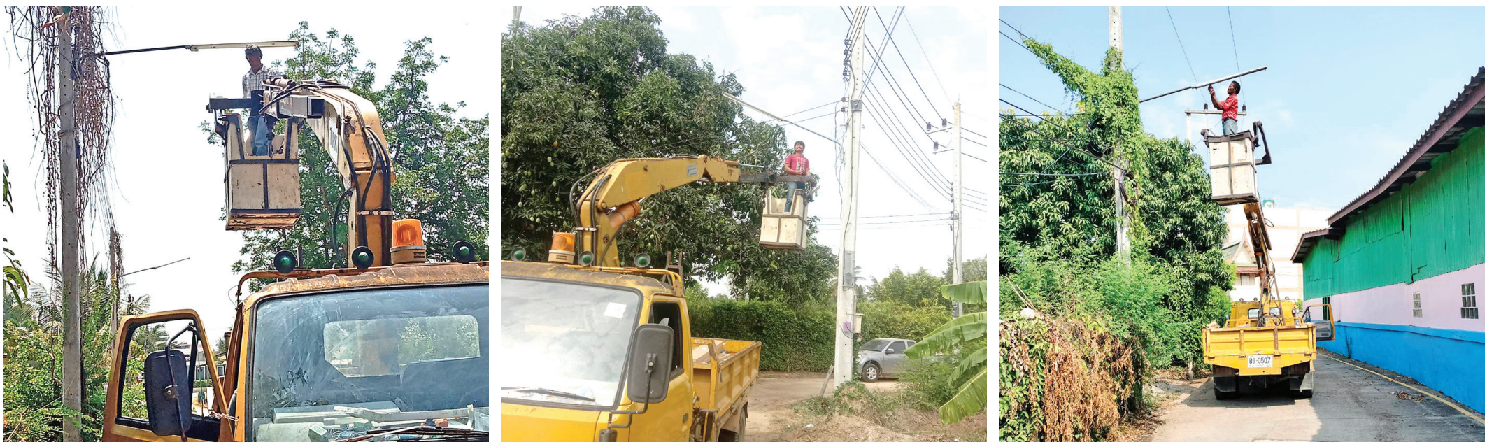
งานซ่อมไฟทางสาธารณะ
