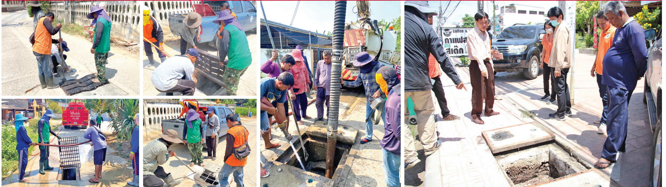
งานบำบัดน้ำเสีย ร่วมกับ งานป้องกันและบรรเทาสาธารณภัย เทศบาลตำบลท่ายาง ปฏิบัติหน้าที่ทำความสะอาดเส้นท่อระบายน้ำสาธารณะในเขตเทศบาล พร้อมกำจัดสิ่งปฏิกูล และคราบไขมัน ตามแผนการดำเนินงาน ประจำปี 2567
