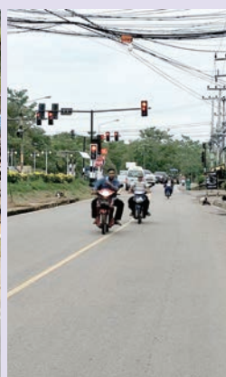
ก่อนติดตั้งสัญญาณไฟจราจร
